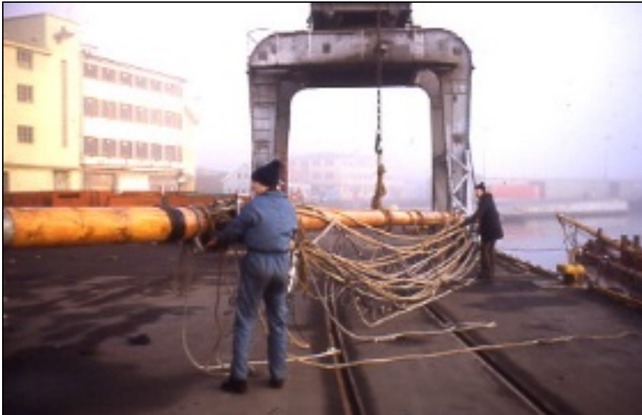
Kaikran ble brukt til å sette opp mastene
